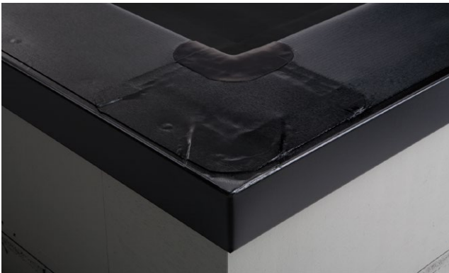
Ortgangprofil mit Außenecke
