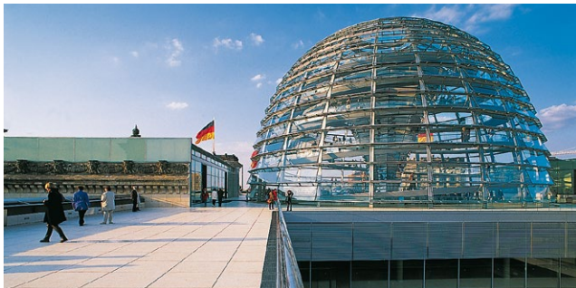
Sicher abgedichtet mit dem Wolfin PYE-System: Das Dach des Reichstags in Berlin.
