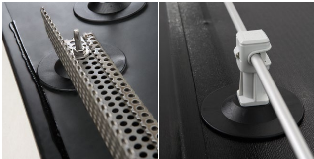
Befestigung von Kiesfangleisten
